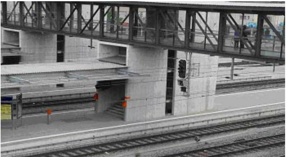
HB Spiez, Passerelle mit Treppenaufgang, Original
